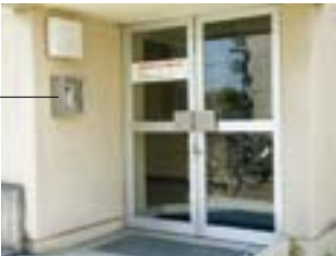
建物玄関 防犯用に「カードロックシステム」を導入。 入館の際、学生証をカードリーダーに通して入ります。
